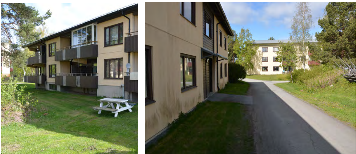
Figur 4. Exempel på byggnader i området Skifteslaget. I bilden till vänster kan man se att vatten som uppgår till 0.5 meter kommer tränga in i byggnaden via källarfönster. I bilden till höger ser man entré till byggnaden som är i markplan, vilket leder till inträngning av vatten om det blir stående mot fasaden (bilder tagna av Thomas Stoll).
