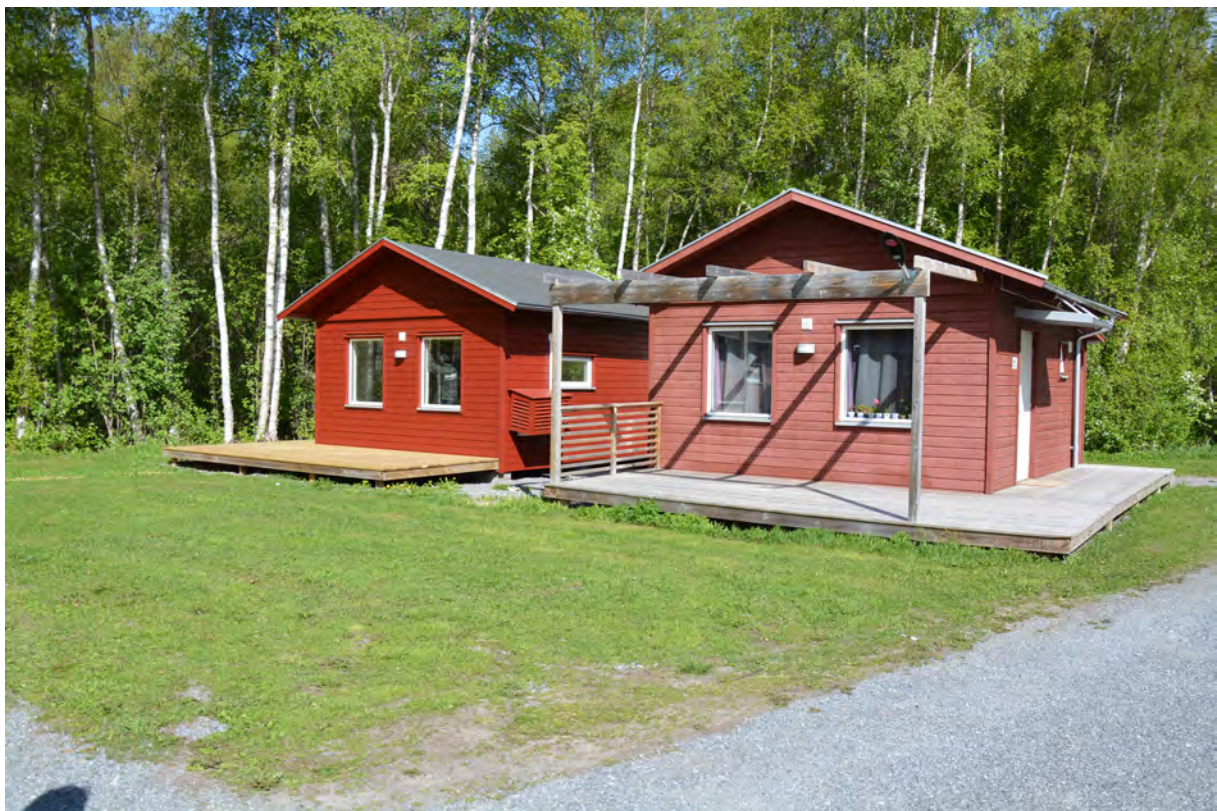
Figur 5b. Exempel på byggnader som enligt karteringen riskerar att få 0.1-0.3 m högt vatten mot fasad. Då husen står på printar kan detta leda till allvarliga konsekvenser där husen rör på sig och i värsta fall trillar av (Bild tagen av Thomas Stoll).
