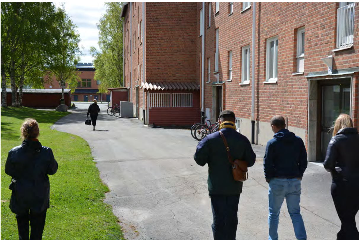
Figur 10. Byggnad inom området Hjorten där vatten beräknas stå mot fasad. Som kan ses i bilden är entréerna i markhöjd vilket riskerar att leda till vatteninträngning (Bild tagen av Thomas Stoll).
