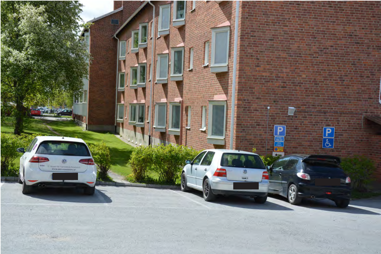
Figur 9. Byggnad inom området Hjorten som riskerar att få stående vatten på upp emot 1 meter mot fasaden. I bilden går det att se att marken sluttar ner mot byggnadens hörn, vilket riskerar att leda till att vattnet fortsätter att flöda hitåt även efter skyfallet. Det går även att se att byggnaden har källarfönster, vilket kommer leda till vattenintrång (Bild tagen av Thomas Stoll).
